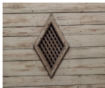
木吊顶菱形通风洞口
