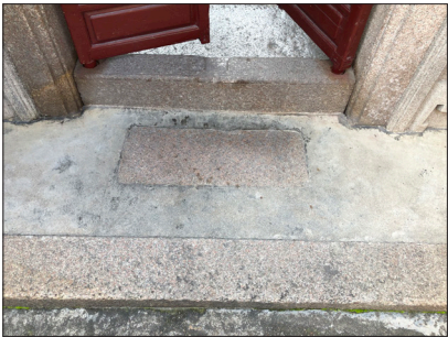
民居主入口处理
