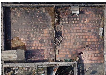
屋顶阶砖铺装
