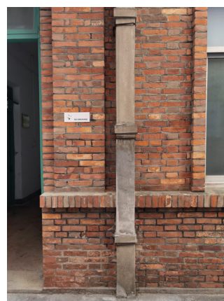
水刷石饰面落水管，方形竹节状
