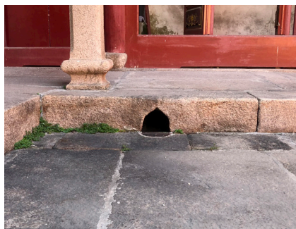
天井排水通道畅通
