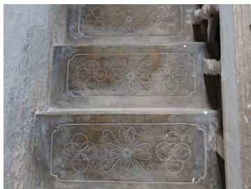
木楼梯上加水泥压花面层
