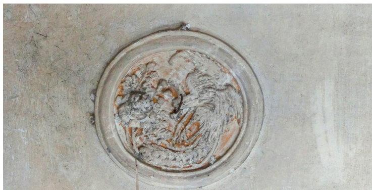
木楼板加石膏装饰
