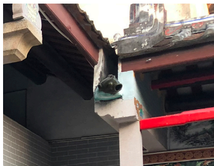
天沟排水无堵塞
