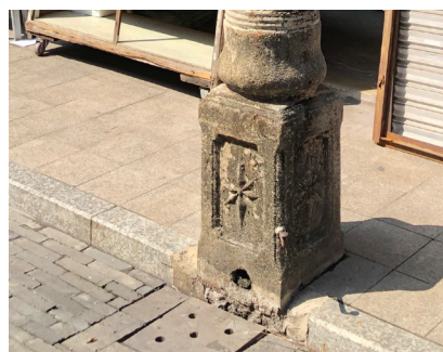
骑楼内部排水管正常运行
