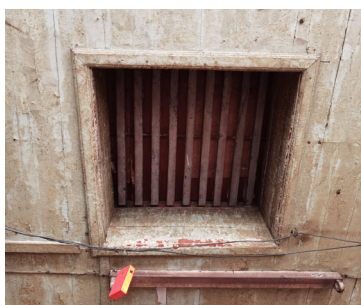
骑楼室内方形洞口
