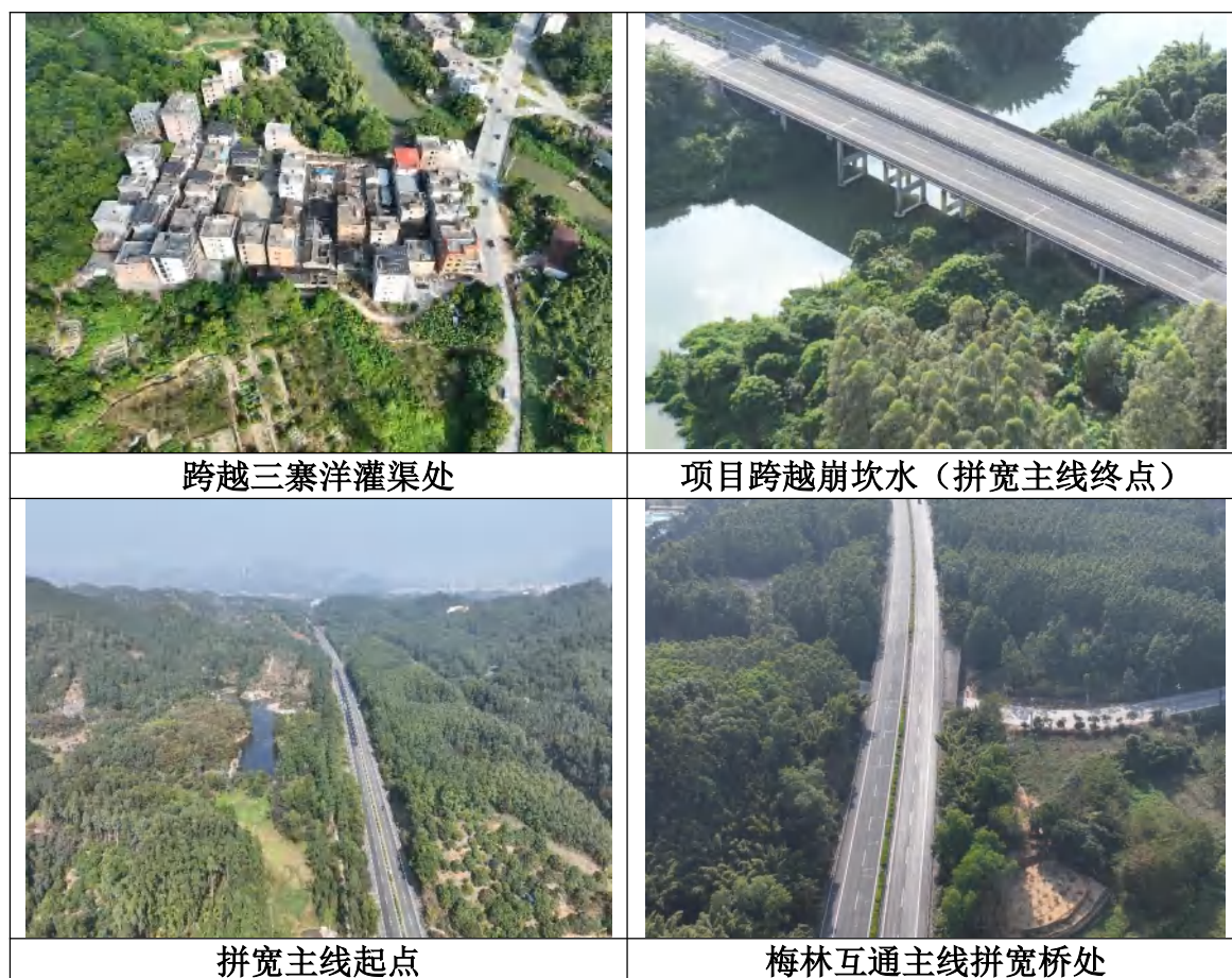
图 2.4-1 项目现场照片
