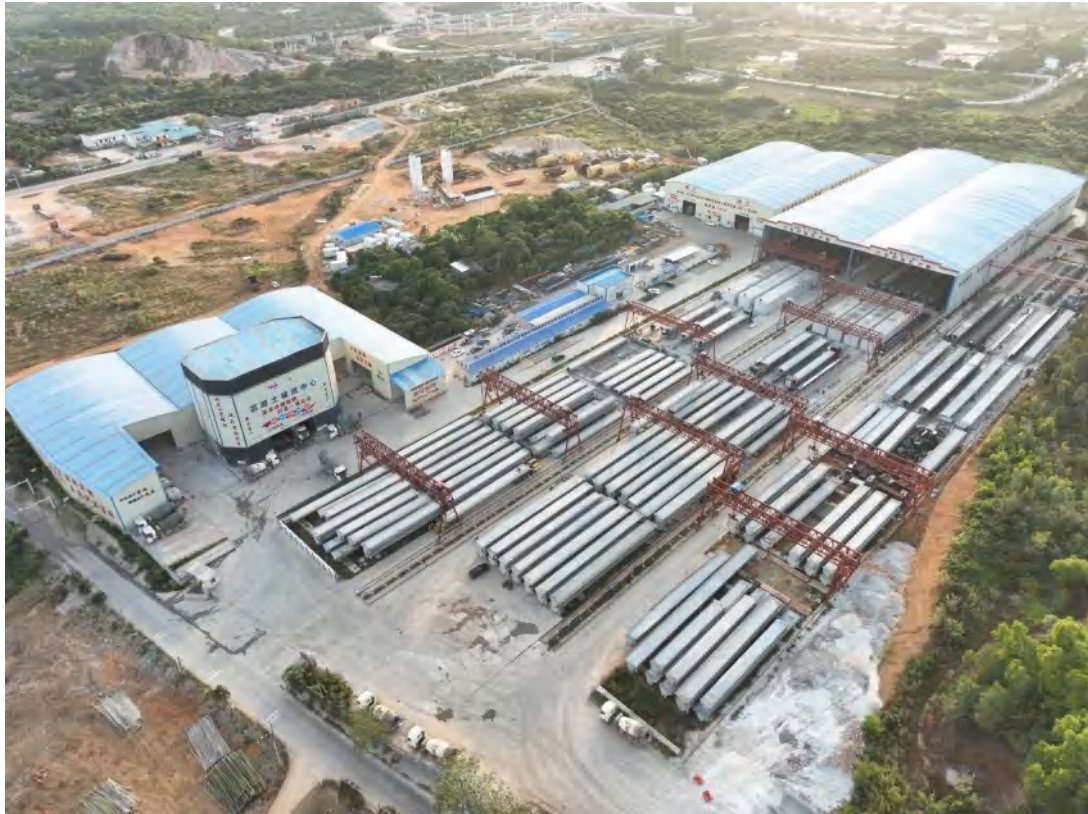
图 2.4-2 预制梁厂、钢筋加工厂现场照片
