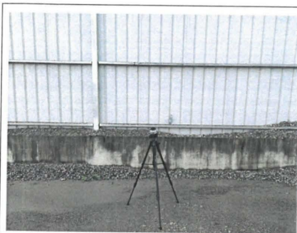
图7.7 项目厂区南侧边界外1米处 ▲N3
