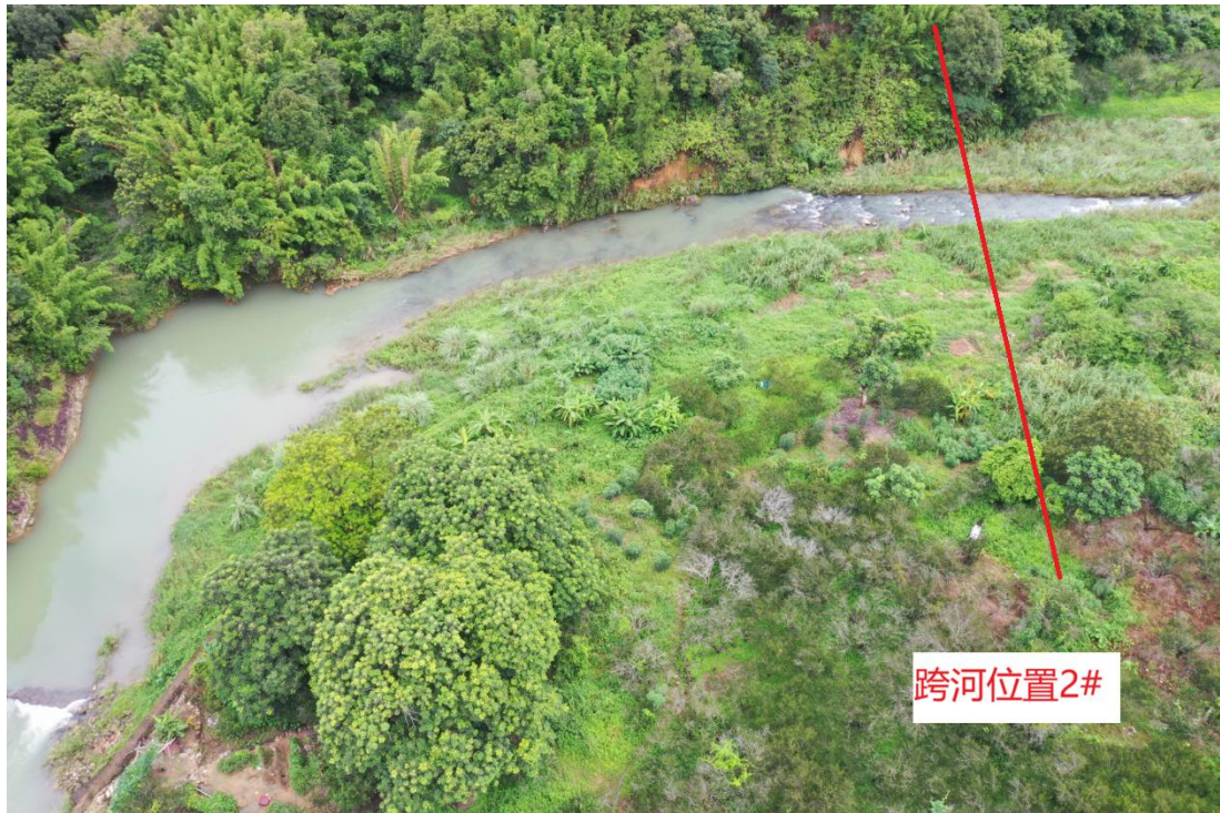
图 1.1-5 陆河至惠来高速公路工程跨龙江 2#位置现状（跨河位置）
