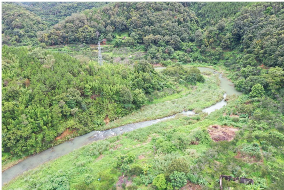
图 1.1-4 陆河至惠来高速公路工程跨龙江 2#位置现状（上游）
