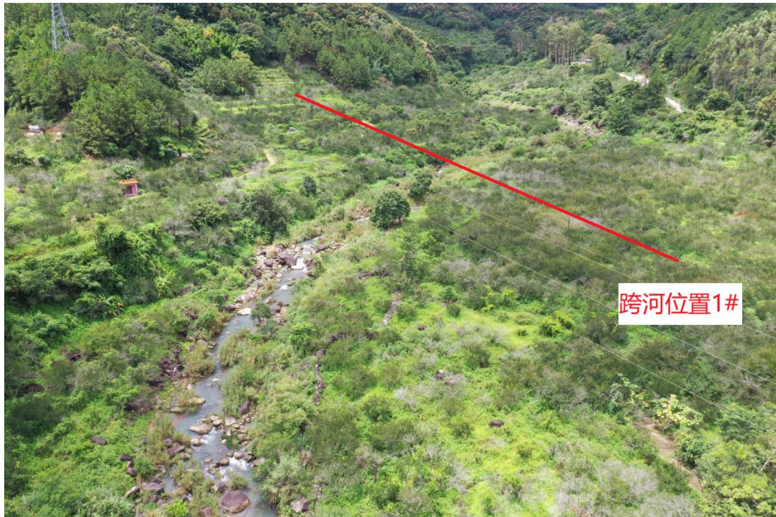
图 1.1-3 陆河至惠来高速公路工程跨龙江 1#位置现状
