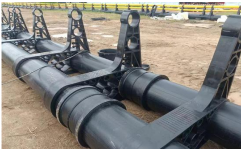
图 2.3.1-1 支架安装示意图
