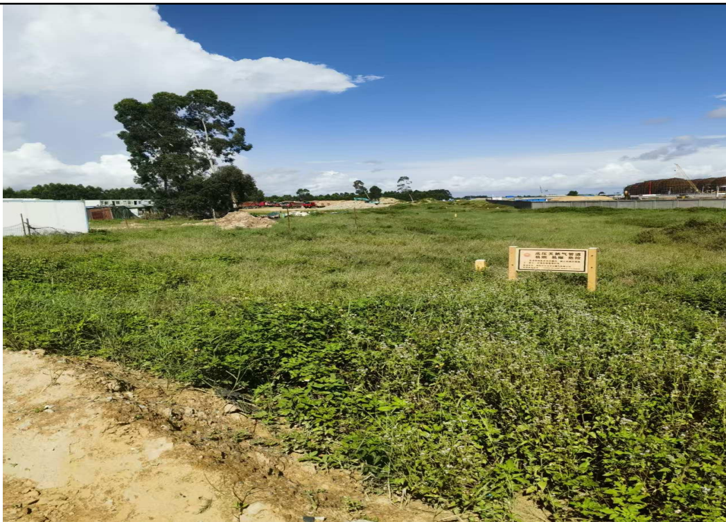
管道路由现场情况
