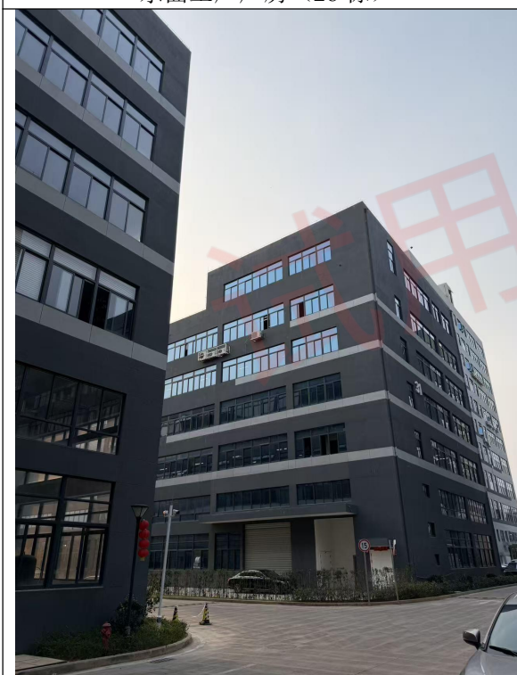
北面工厂厂房（31 栋）
