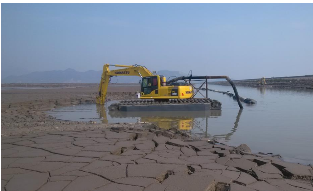
图 2.3.1-1 水力冲挖机组施工示意图
