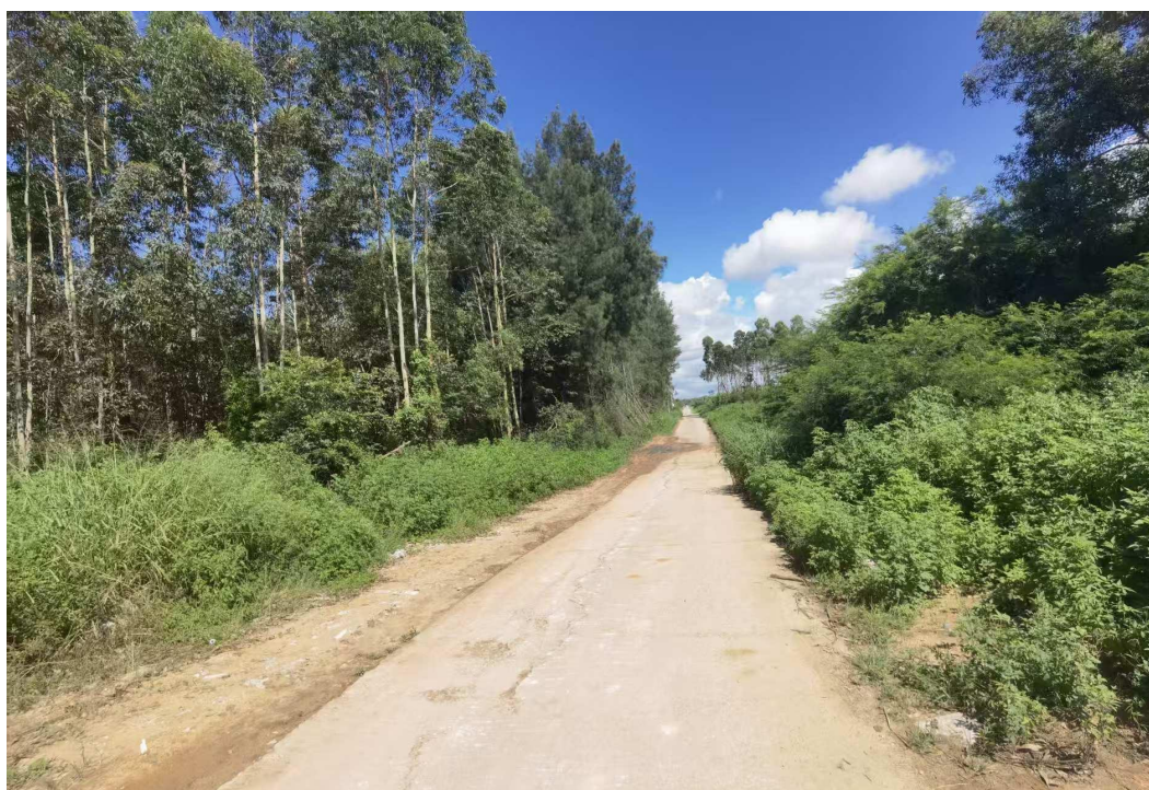
管道路由现场情况
