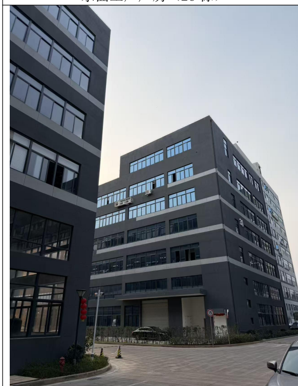
北面工厂厂房（31 栋）
