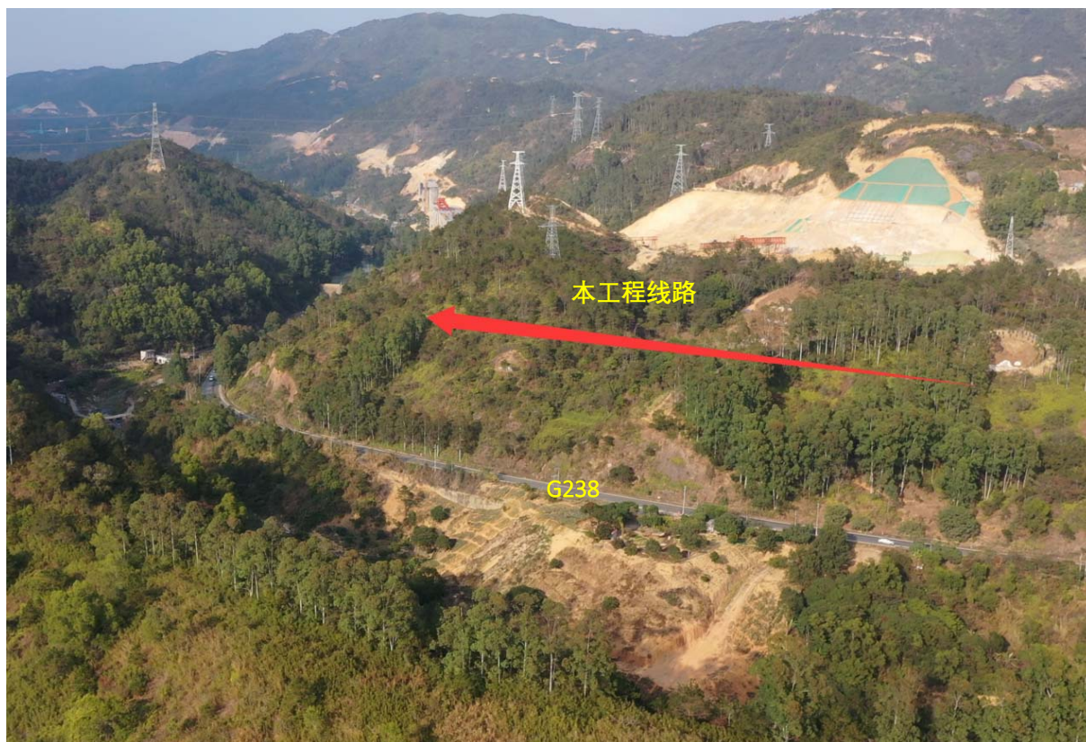
图 1 项目途经石榴潭水库饮用水水源保护区（二级陆域保护区）现状照片
