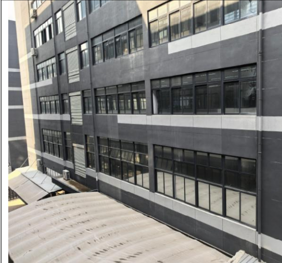
北面为工厂厂房
