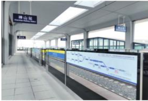
广清城际铁路南延线神山站。通讯供图
