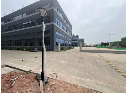
东面：道路和厂房
