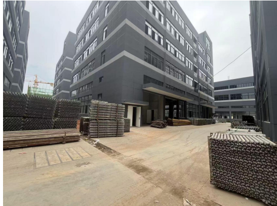
北面：道路和厂房
