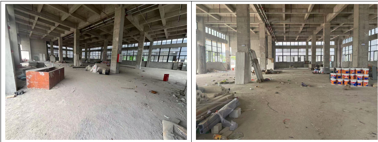
厂房内部现状相片
