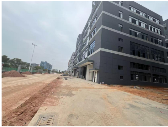
西面：道路和厂房
