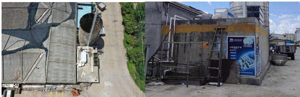
事故库房西侧室外景照片
