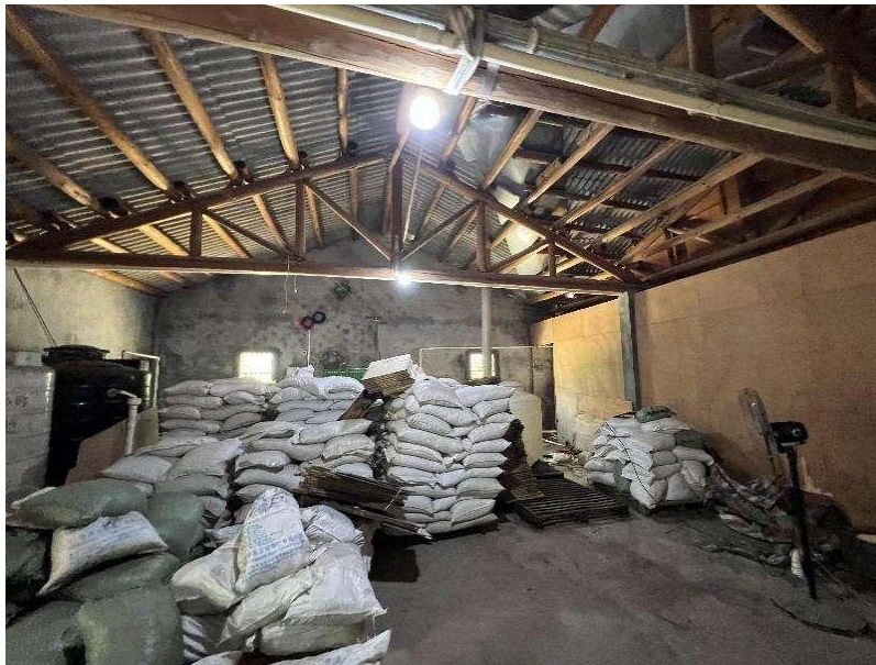
分隔木板西侧（事故库房）内景照片
