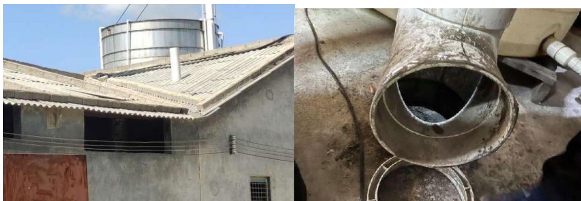
事故库房地下 3 号池排废气管照片
