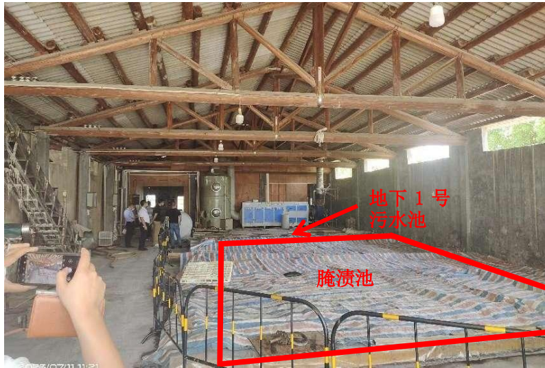
分隔木板东侧（地下腌制池+地下污水处理池）区域照片
