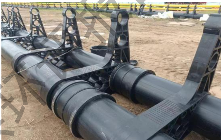
图 3.1.6-4 支架安装示意图
