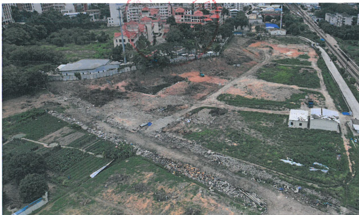
站址现状航拍图
