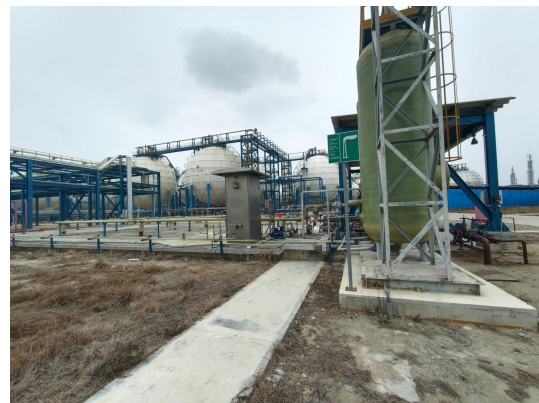
化工中间罐区含油污水池及其废气处理设施现场照片
