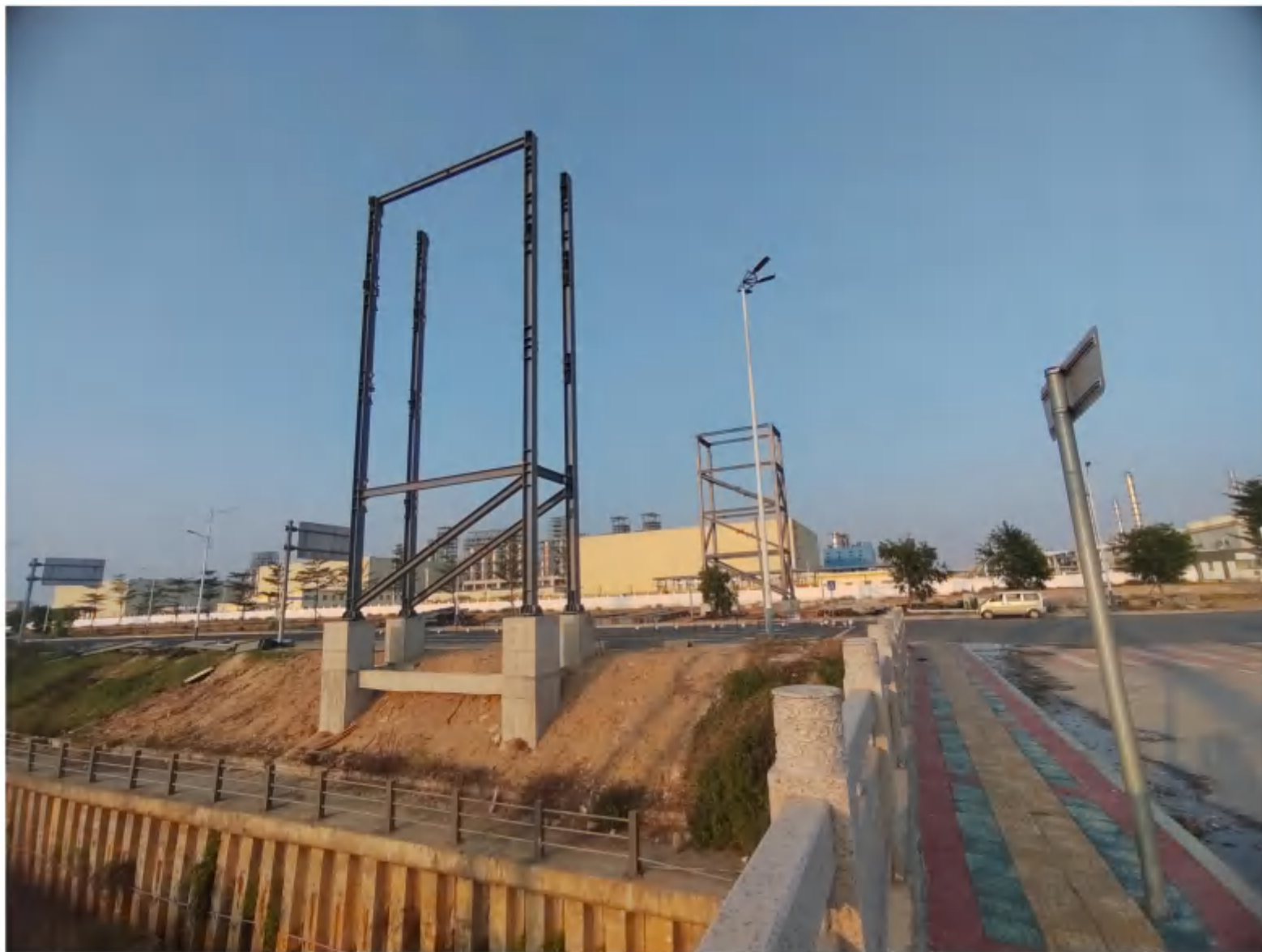
附图 16 公共管廊横跨环海东路现场图
