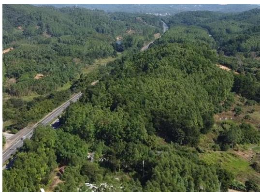
新管道中间定向钻段公益林航拍图
