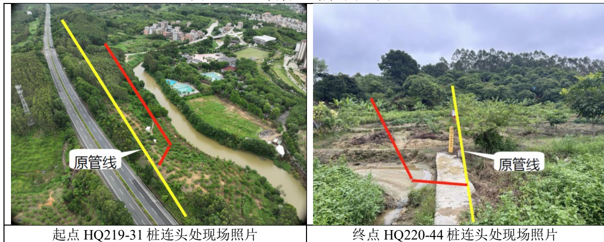
图3.2-6 两处改连头点现场照片
