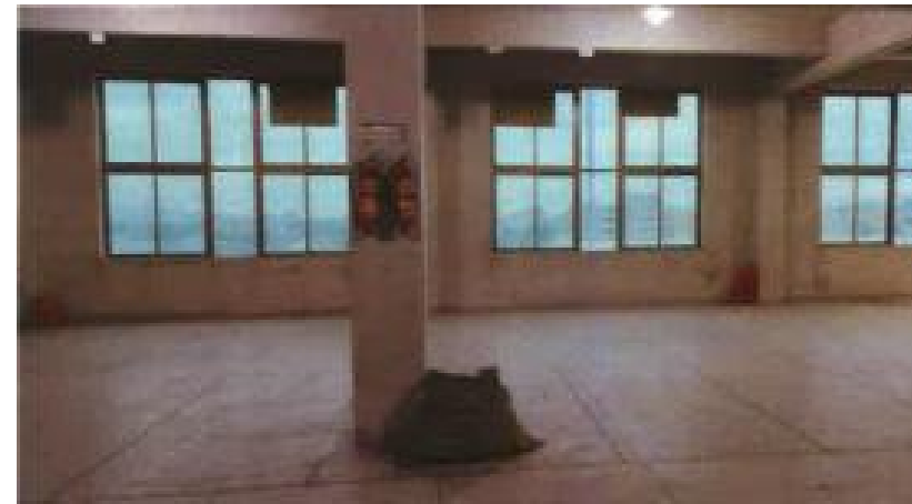
车间硬底化现状
