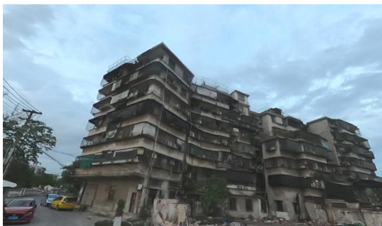
外观风貌不协调的建筑
