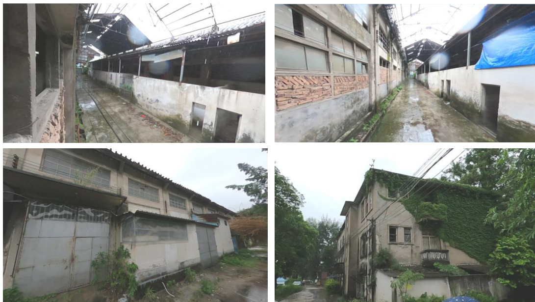
图5-2造船厂老旧厂房（ZCC-07、ZCC-16、ZCC-18）
