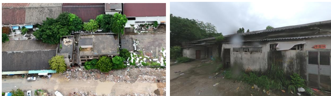
图5-3造船厂老旧厂房（ZCC-10、ZCC-25、ZCC-31）
