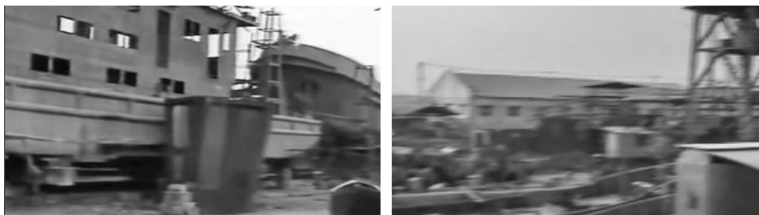
图5-8揭阳市造船厂旧码头、旧船坞照片
