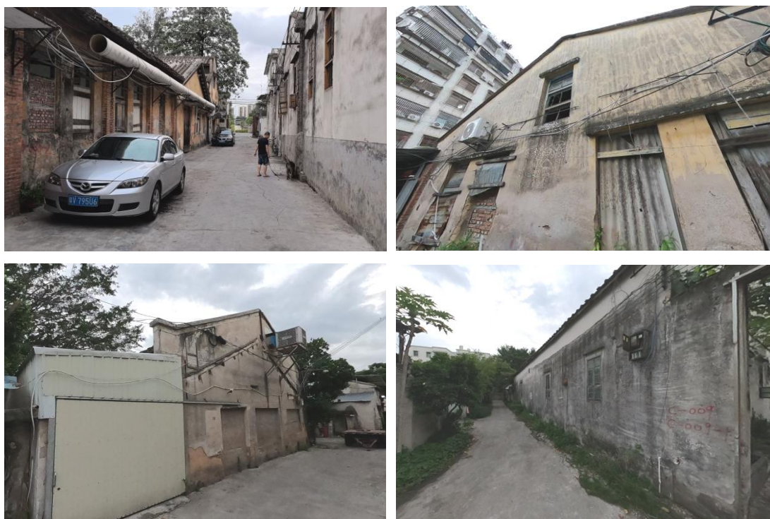
图5-4塑料厂、木材厂厂房（MCC-13、MCC-44、MCC-54）
