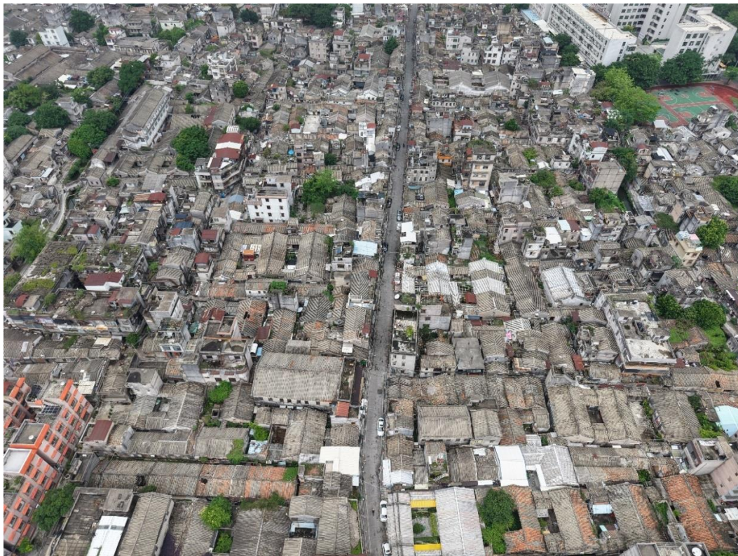
图 4-5 西马路历史文化街区现状航拍图
