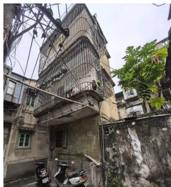
外观风貌不协调的建筑
