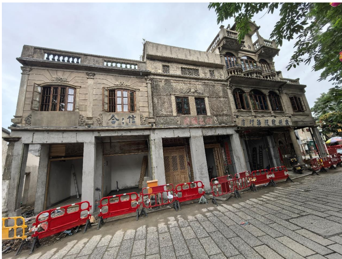
何良顺兴商号及周边建筑照片（修缮中）
