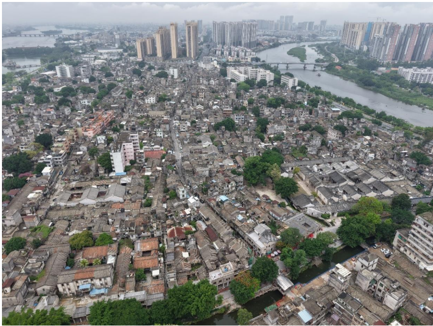
图 4-4 西马路历史文化街区现状航拍图
