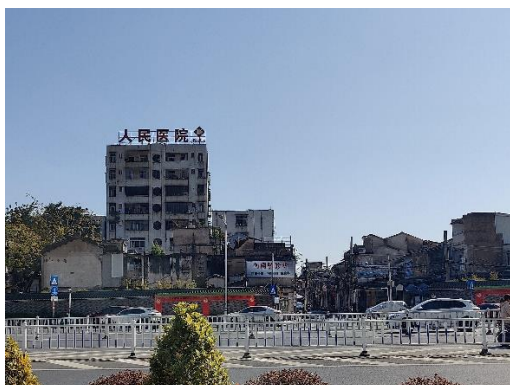
外观风貌不协调的建筑
