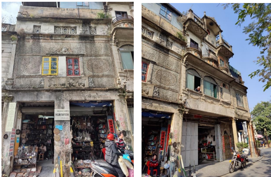
何良顺兴商号及周边现状照片（修缮前）
