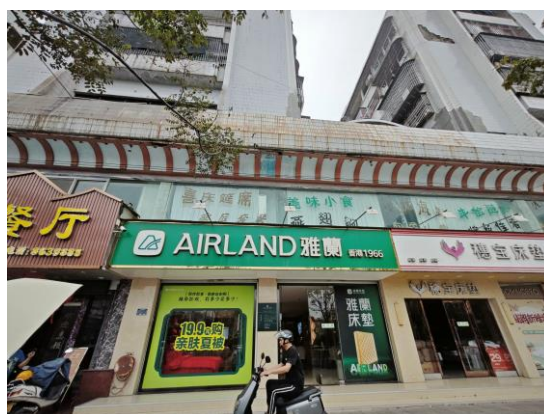
传统风貌不协调的现代建筑
