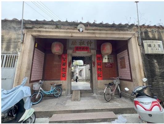
埔上里大门楼内入口
