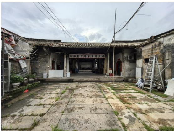
埔上里大门楼内第二进院落
