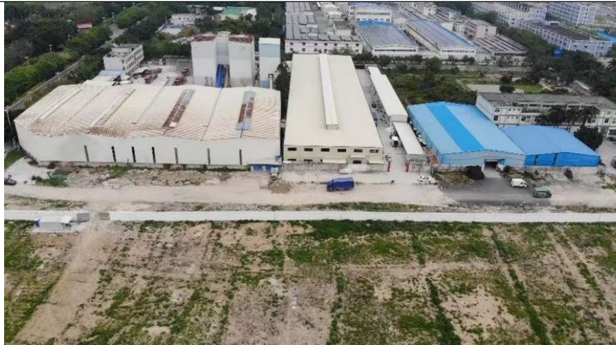
东侧 隔着道路为揭阳市皇马混凝土有限公司
