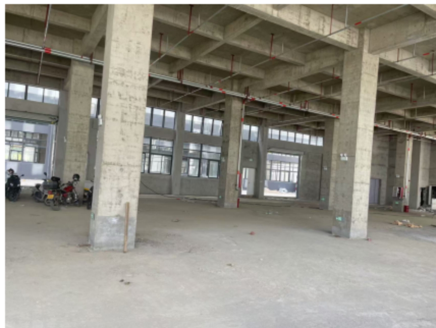
车间现状照片
