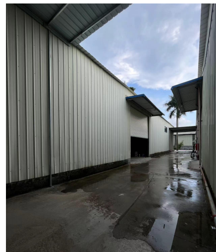
项目东面（隔通道为工厂厂房）
