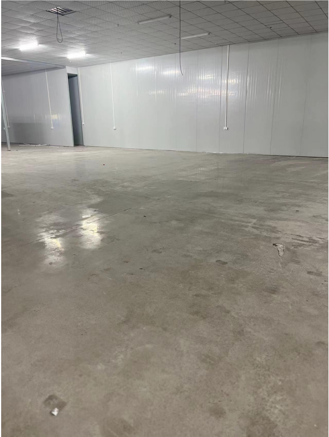
厂房内硬底化地面
