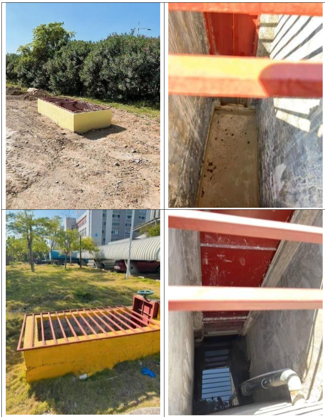
图 3.1-17 表处园雨水管道风险防控改造图
