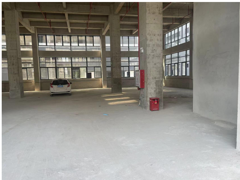
车间现状照片
