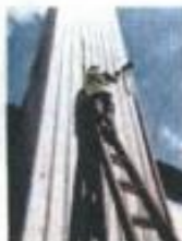
抛光车间1排气筒 (DA001) 处理后
