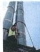
抛光车间2排气筒 (DA002) 处理后
