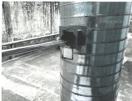
图 9.2 造粒车间废气处理前检测口 ©Q1
