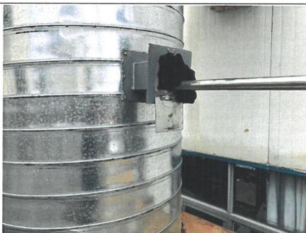
图 9.4 包装车间废气处理前检测口 ©Q3
