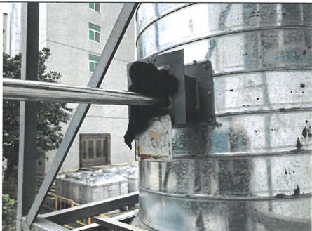
图 9.3 造粒车间废气处理后检测口 (DA006)
