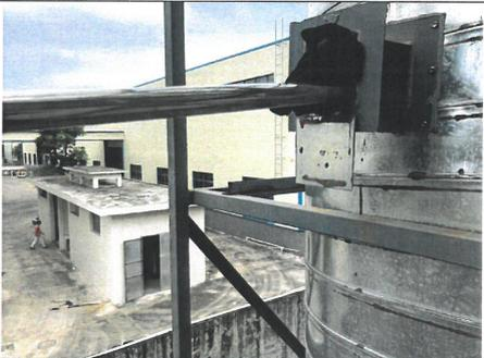
图 9.5 包装车间废气处理后检测口 (DA005)
