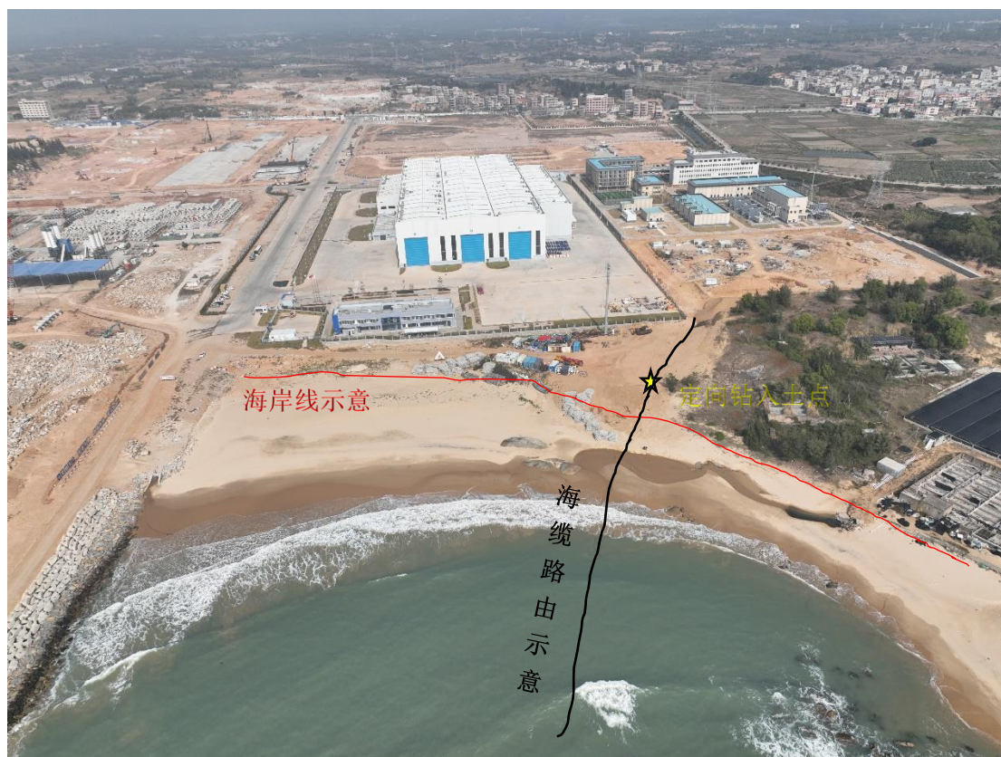
图 2.2.6-5 已完成铺设的登陆点附近岸线情况
