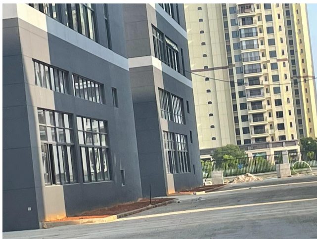
项目西侧 厂房
