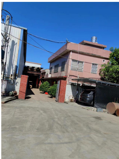
项目北面（工厂厂房）
