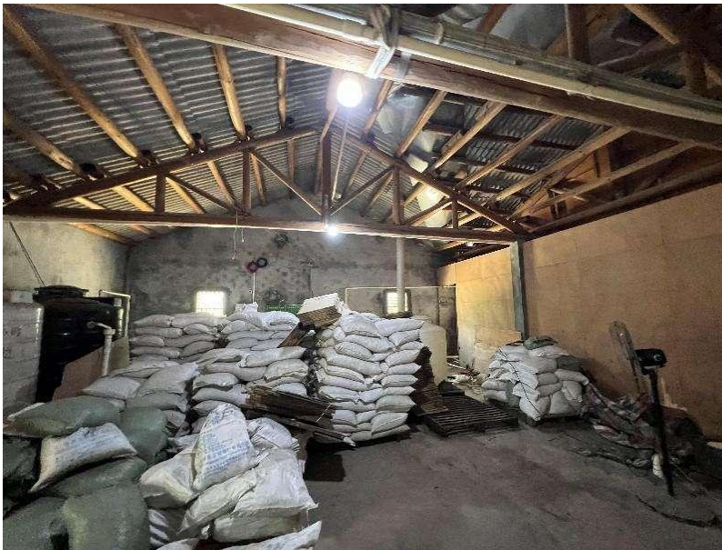
分隔木板西侧（事故库房）内景照片
