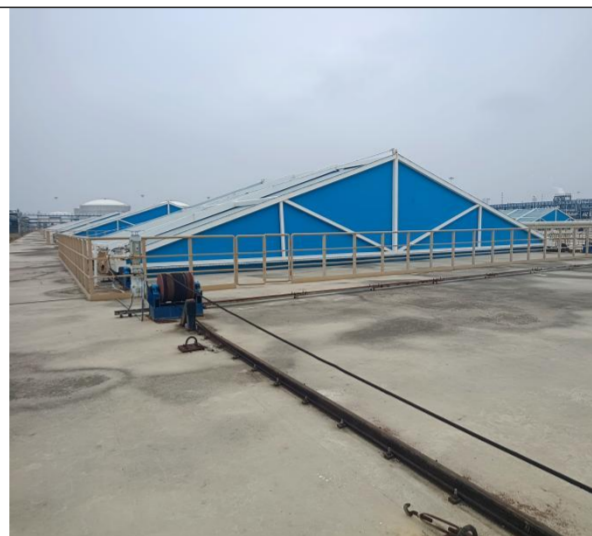
全厂区事故应急池
