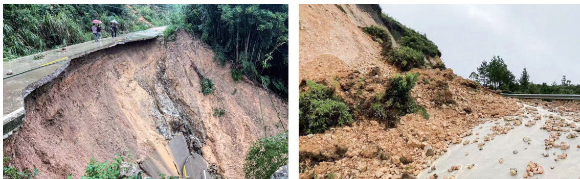
图 11 揭西出现山体滑坡和道路坍塌
