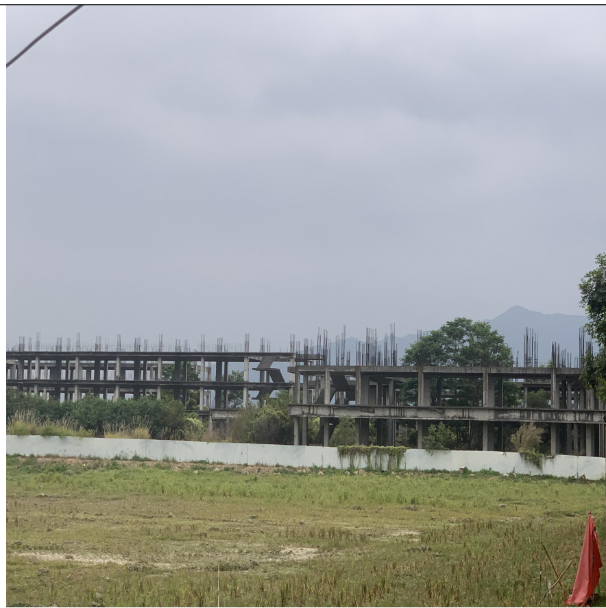
项目南侧（废弃楼）
