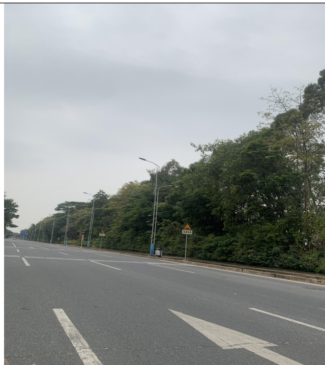
项目北侧（机场路）
