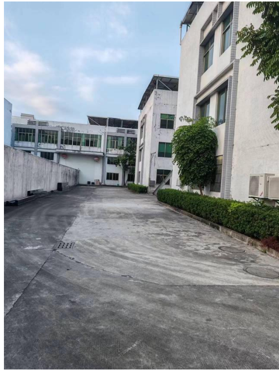
项目西面（厂区通道）
