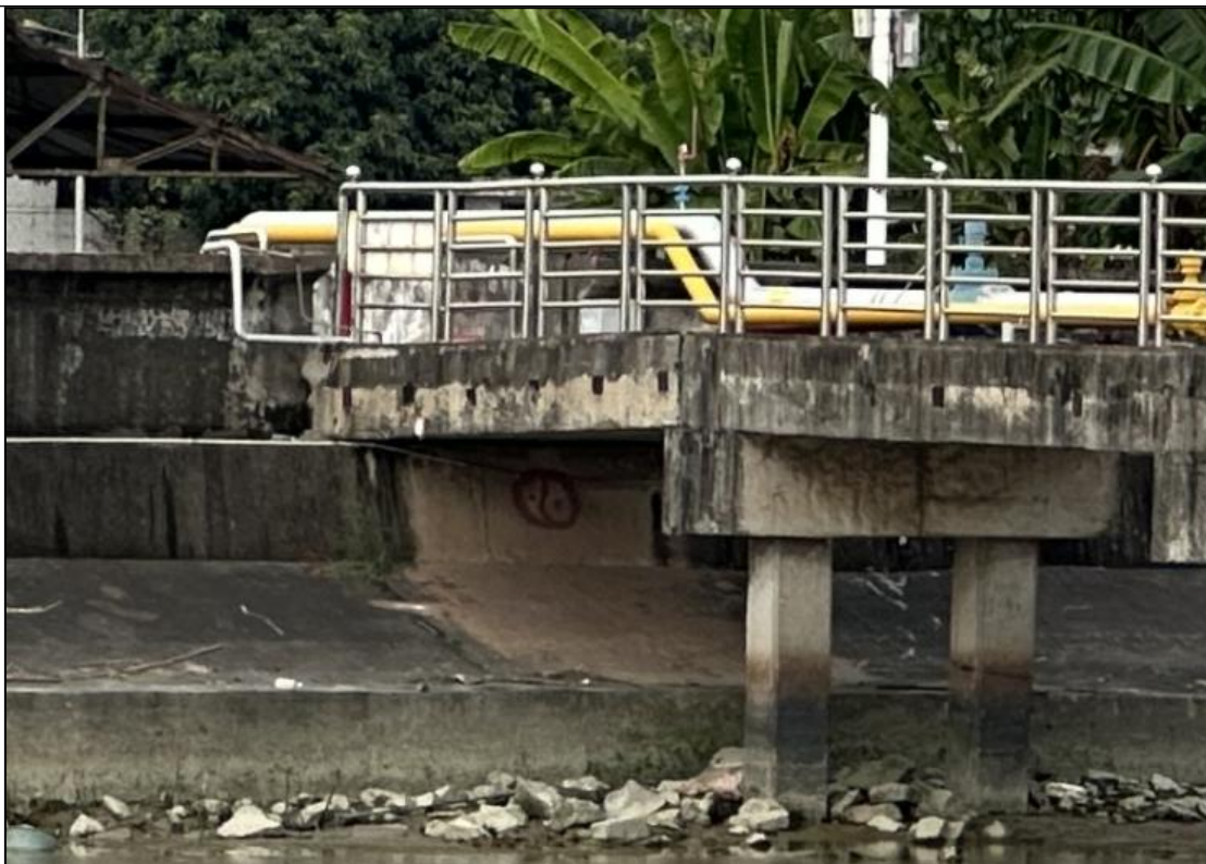
图 1.13-1 本项目接岸情况现状照片
