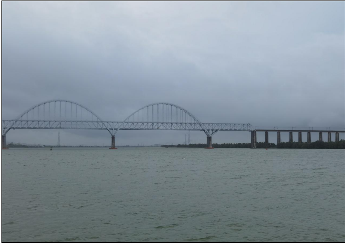
图 4.1-4 厦深铁路榕江特大桥
