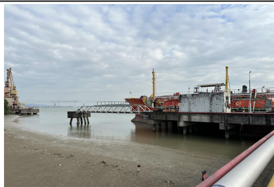
码头平台、钢栈桥、系缆墩现状照片
