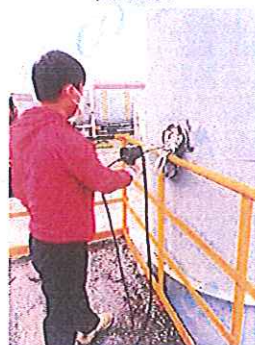
热轧生产线热处理炉烟气处理后排放口 (DA008)
