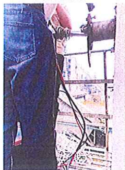
石灰窑焙烧烟气处理后排放口 (DA009)
