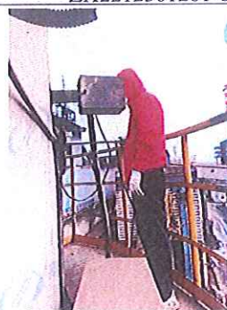
高炉矿槽废气处理后排放口 (DA006)
