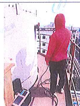
高炉出铁场废气处理后排放口 (DA004)
