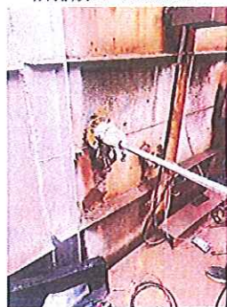
烧结机头废气处理后排放口 (DA0011)
