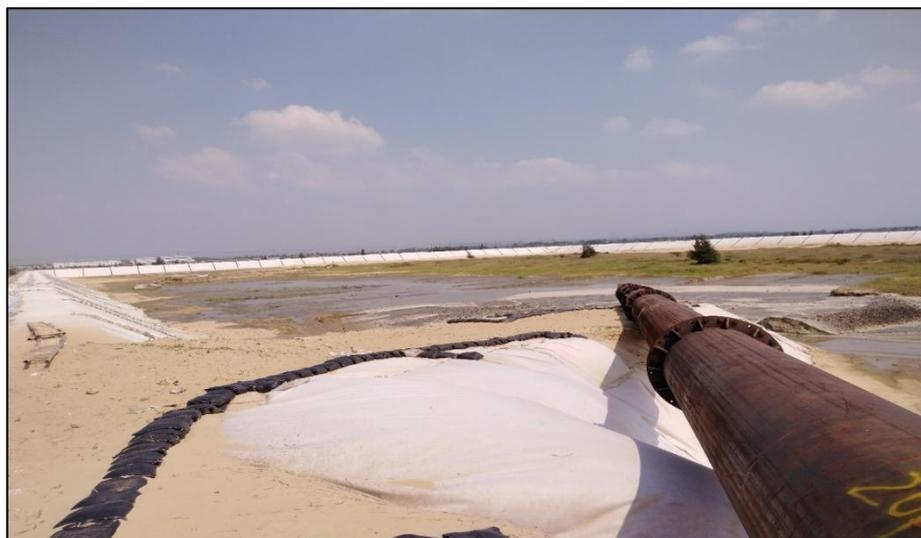
图 2.3.2-3 吹填排泥管布置现场照片
