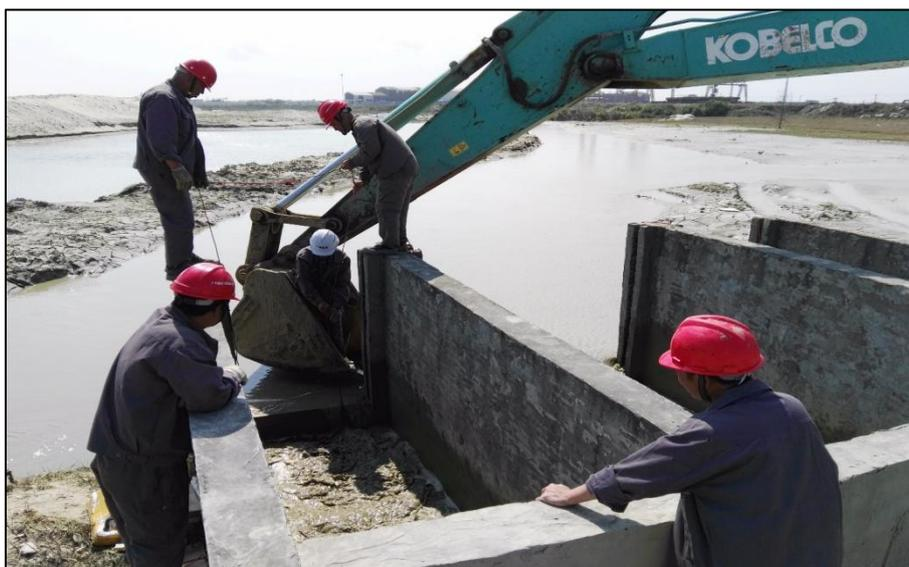
图2.3.2-4 吹填堰式溢流口施工现场照片
