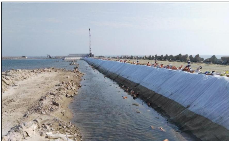
图2.3.2-1 吹填区围堰布置现场照片
