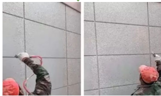
真石漆、水包水/砂机器喷砂
