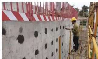
挂金属网、基面腻子施工
