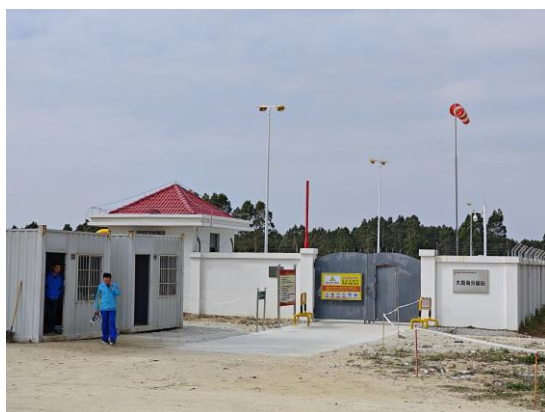
厂界南面揭阳中石油昆仑燃气有限公司
