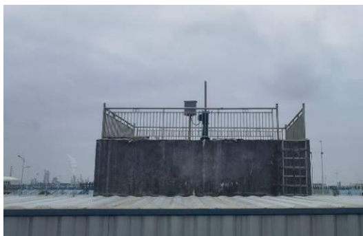
海洋放流管工程监控点
