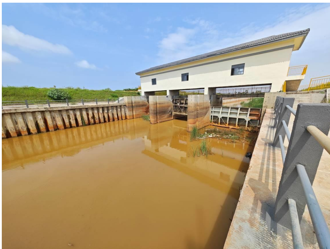
图 8.6-6 (b) 西排洪渠上游的闸门的照片
