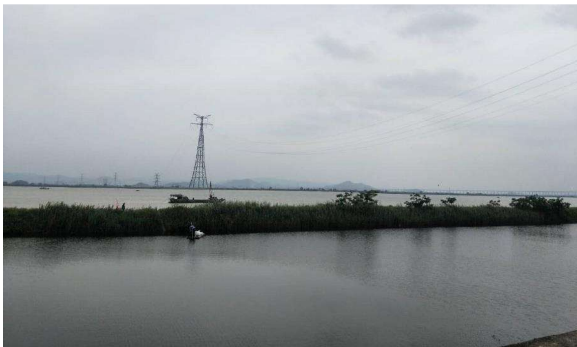
图 4.3-9 潮南-汕头 500kv 输电线路
