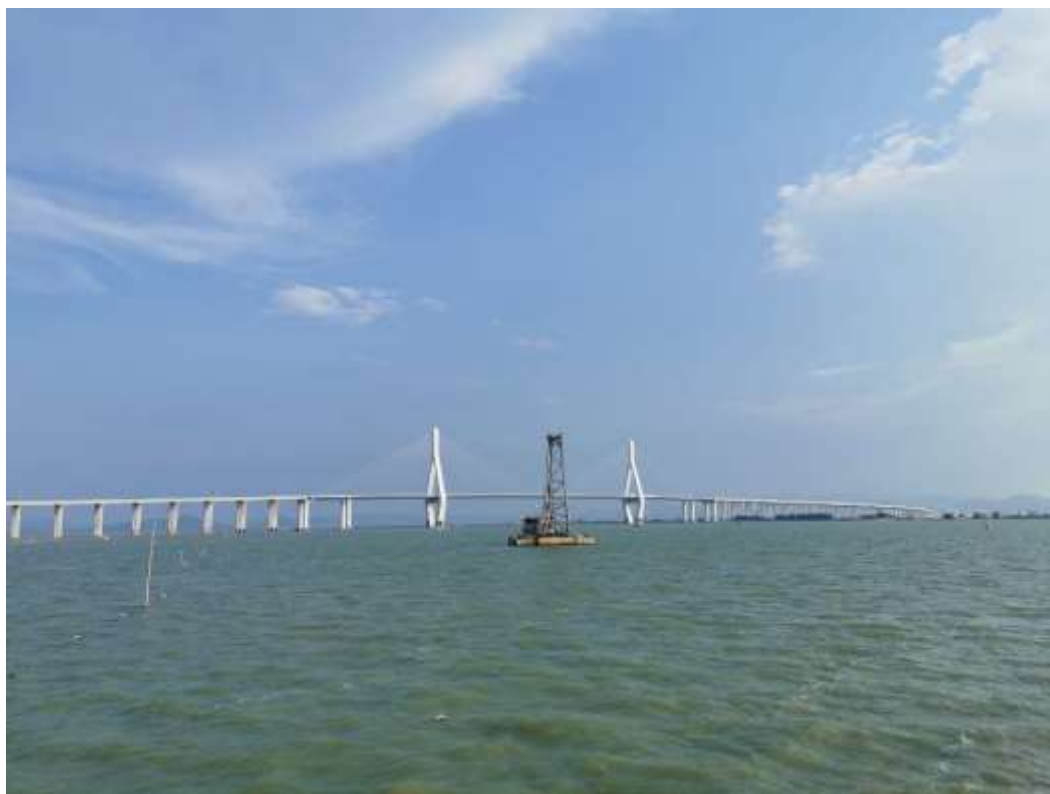
图 4.3-8 潮汕环线高速公路榕江特大桥（在建）
