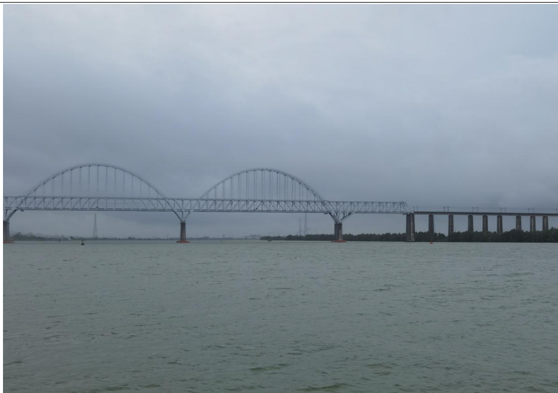
图 4.1-5 厦深铁路榕江特大桥
