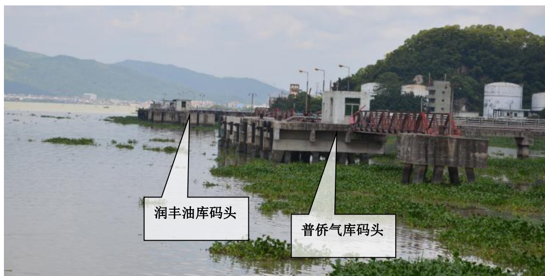
图 4.1-3 普侨气库码头、润丰油库码头
