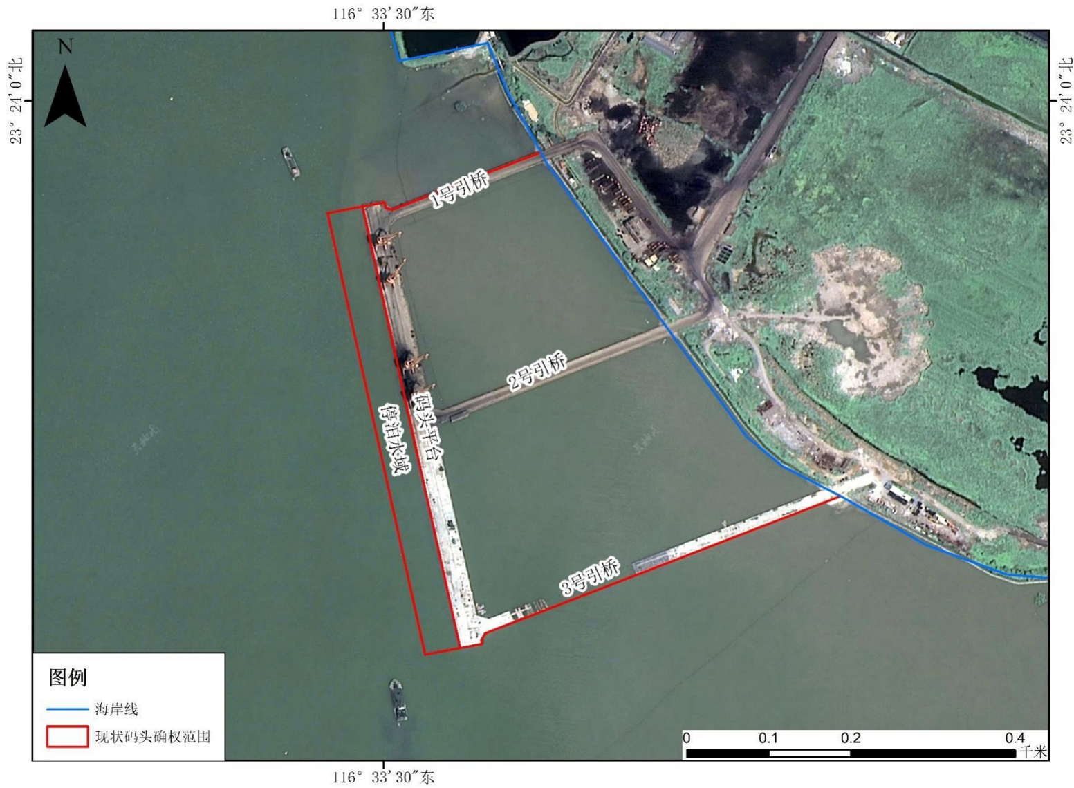
图3.2-4 已建码头工程现状图
