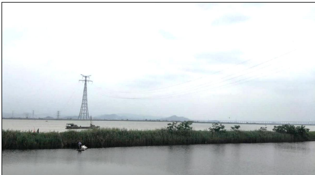
图 5.2-8 潮南-汕头 500kv 输电线路
