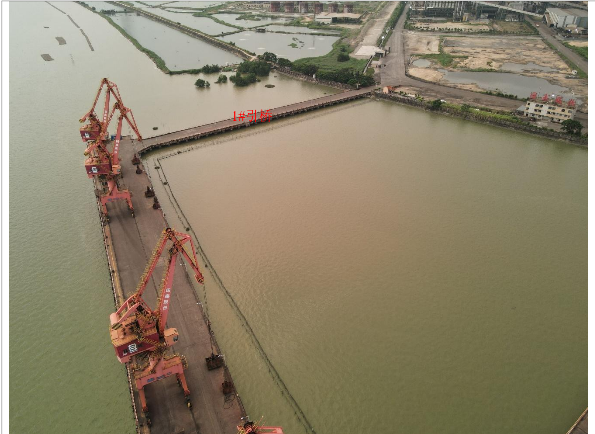
码头及港池区域现状
