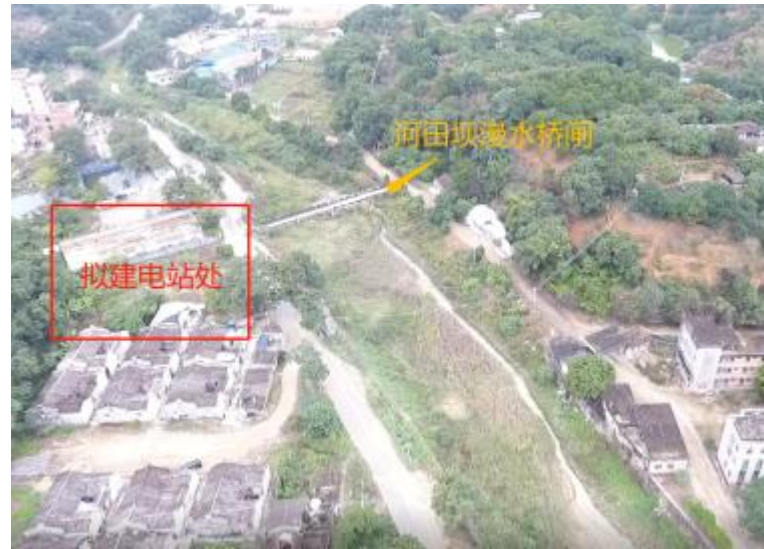
拟建水电站处
