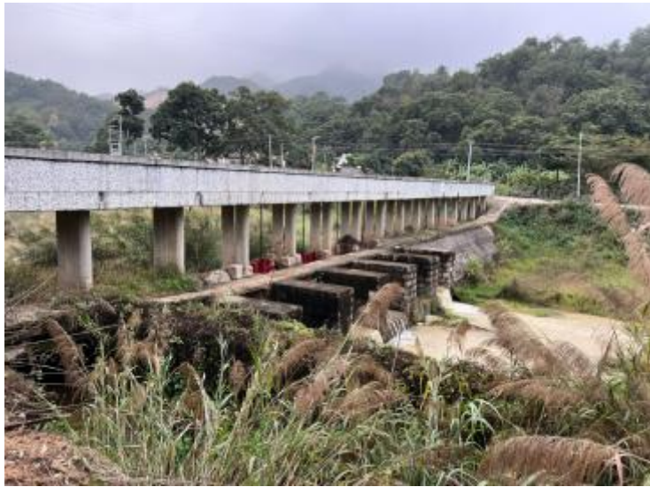
河田坝漫水桥闸
