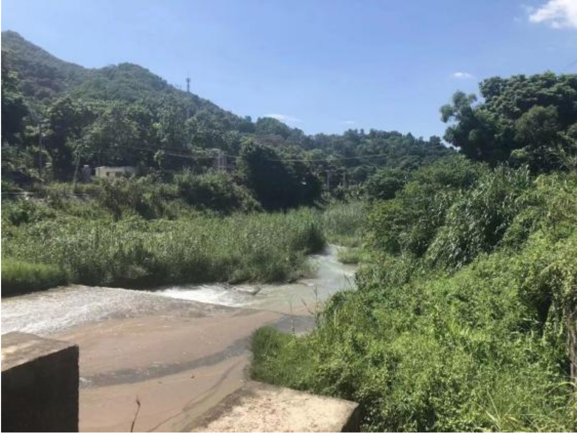
图 4.9-3 河田坝漫水桥闸
