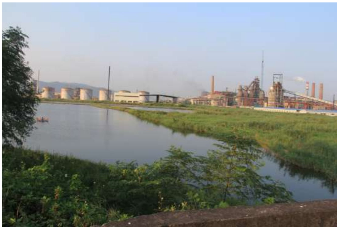
图 4.4.7-3 防洪海堤内侧养殖鱼塘现状
