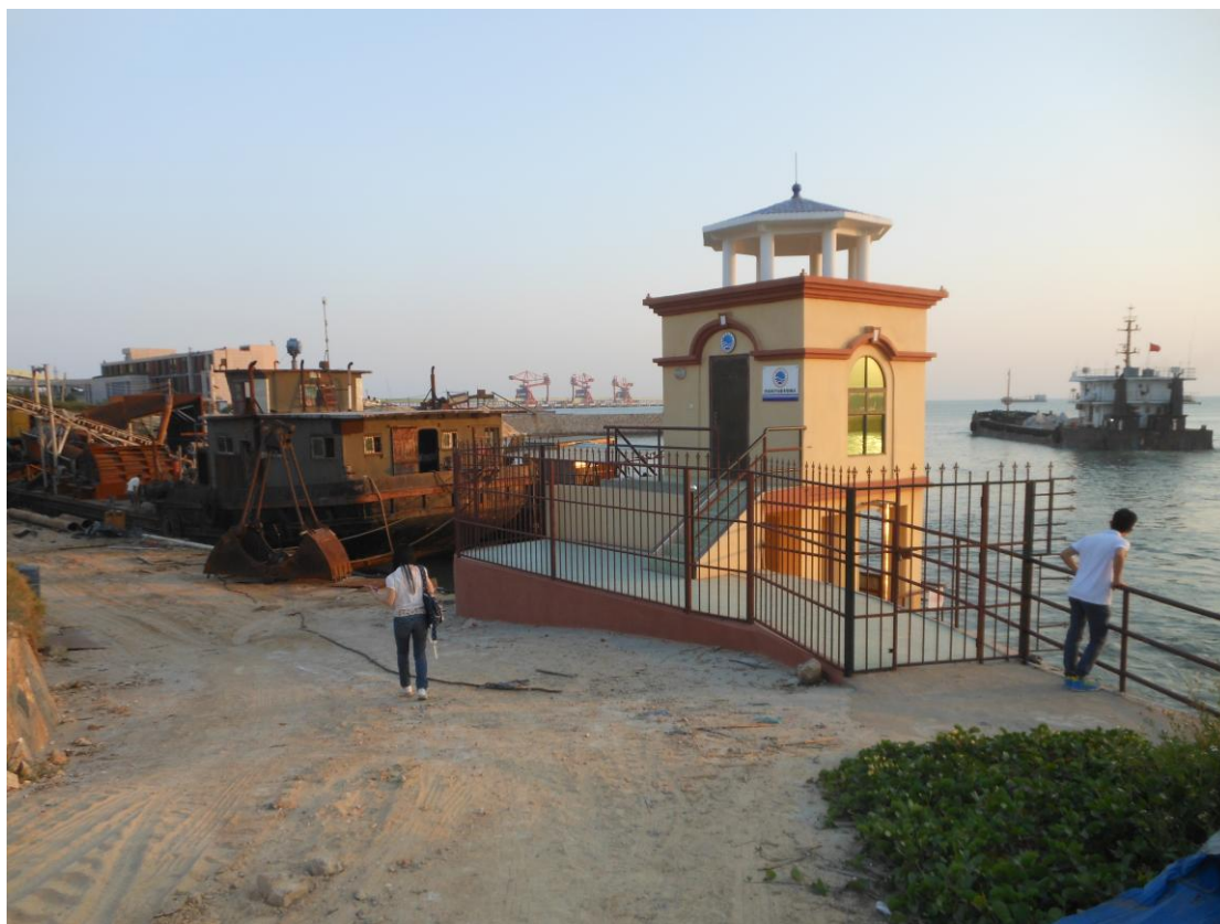
图 4.4.5-4 项目北侧靖海监测站（与惠来电厂紧邻）
